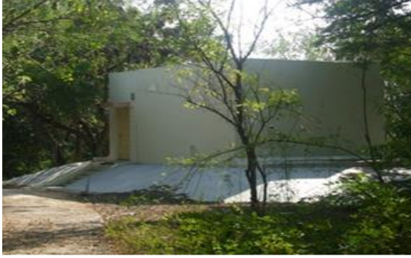
प्राथमिक वैरिओमीटरभवन Primary variometer building
